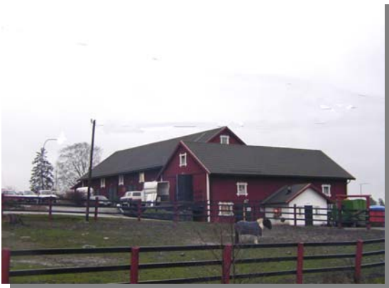
F.d. ladugården, uppbyggd efter brand
