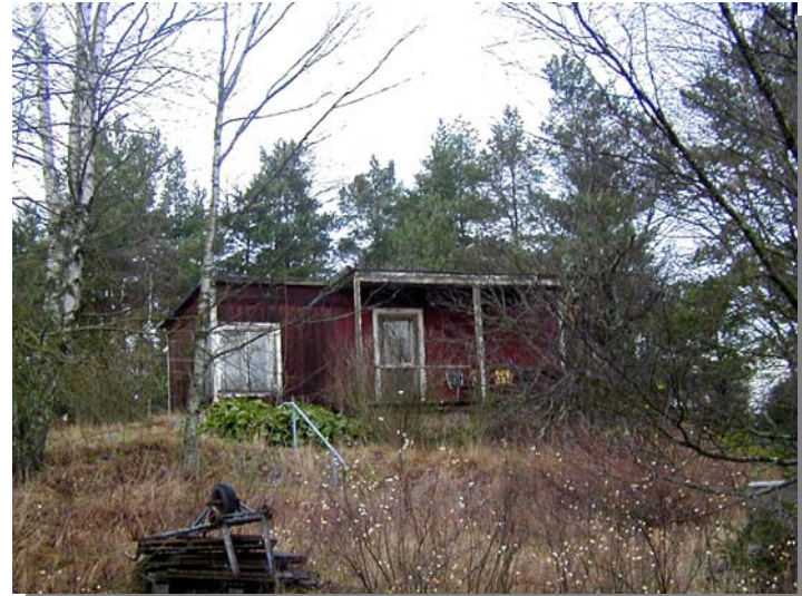
Backstugan, byggd av "billådor"
