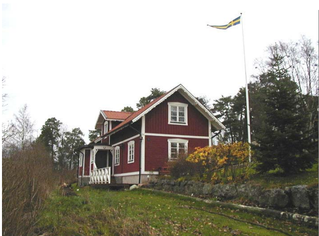
Hyddan, närmast vägen, renovering pågår.
