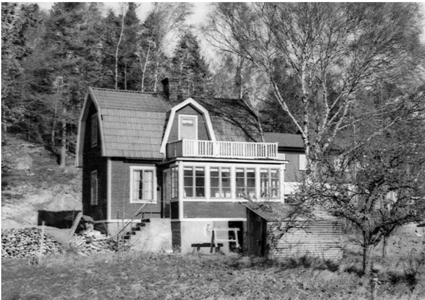
Baksidan som visar verandan som öppnades upp när sommarvärmen började komma.
