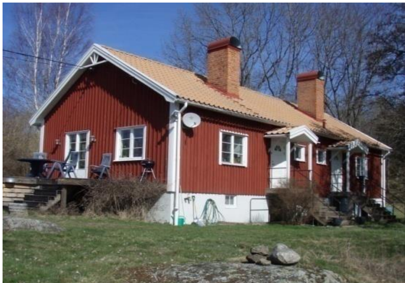
Nuvarande Kråkvilan, uppförd 1948.
