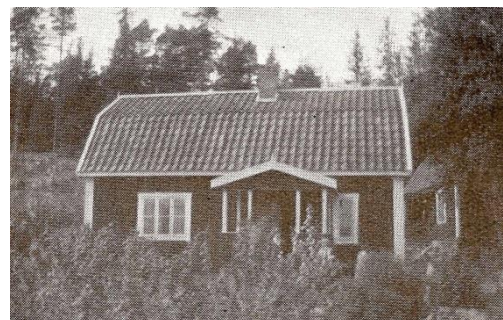
Norrgården efter renoveringen 1937.
