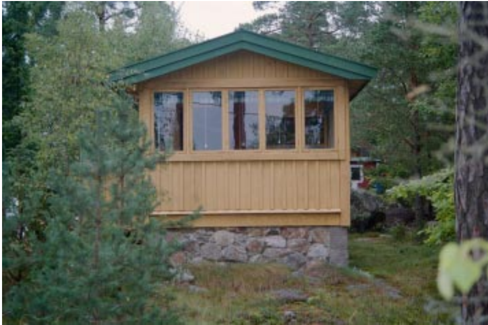
Årstastuga. Utsiktsvägen 33. Grund med stenmur mellan plintarna.
