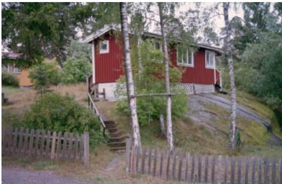
Stuga med grund både med liggande panel på förvandring och krysspaljé.
