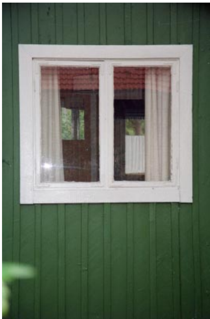
Fönster med hörnjärn och enkla, släta foder.
