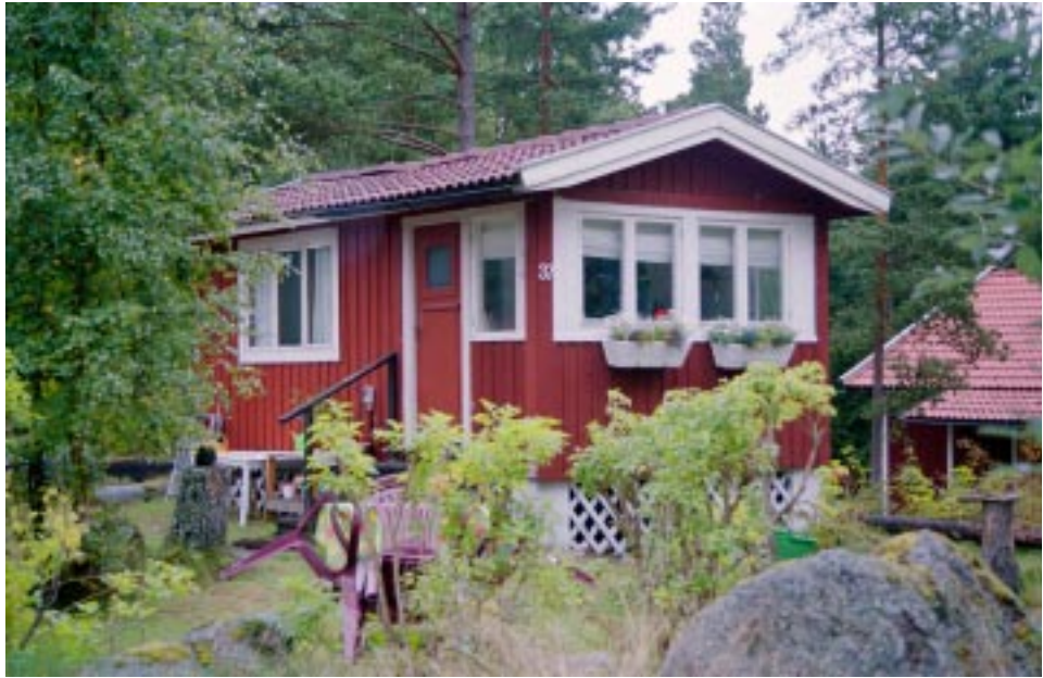
Idrottsvägen. Stuga med inbyggd veranda. Krysspäljéer mellan grundplintar. Bevarad entrédörr.
