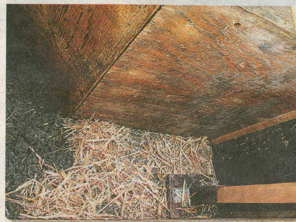
En mycket ovanlig och okänd teknik upptäcktes i den nästan 400 år gamla mjölnearbostaden. Lera varvas med halm i skikt.
