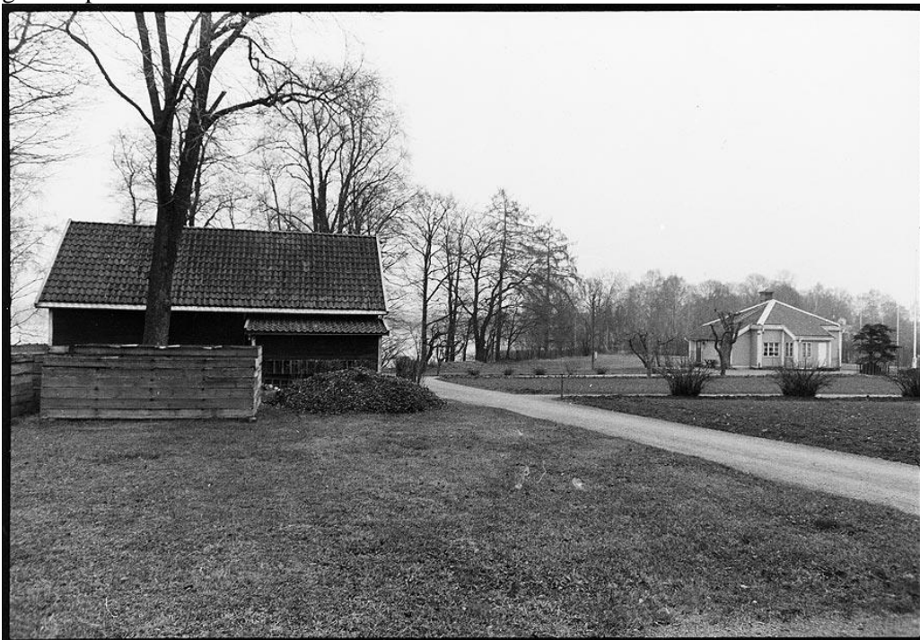
Grundläggarns uthus och trädgårdsmästarbostaden. Foto från 1984
