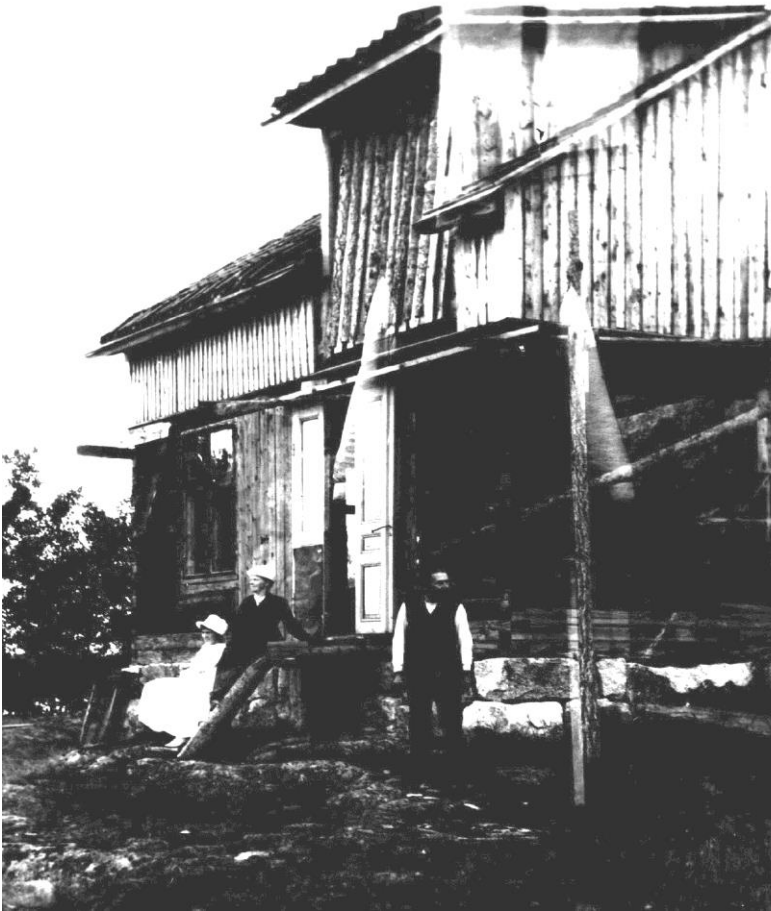
Bild 3. Carl Norrström. Dubbelexponerad under byggnationen.
