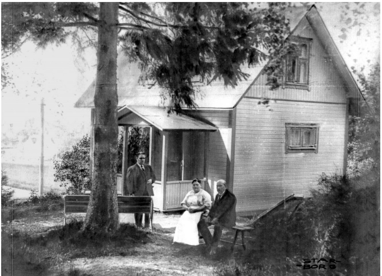
Framför huset på Oxhagsvägen c:a 1930, Karl, Hilma och August Magnusson.
