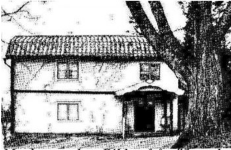
Mangårdsbyggnaden 1939. Återstår nu bara grunden.
