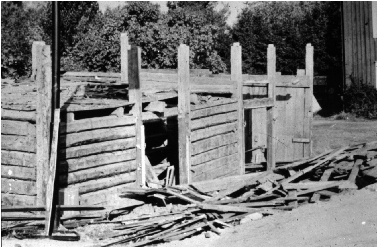
"Fånghuset" under rivning
